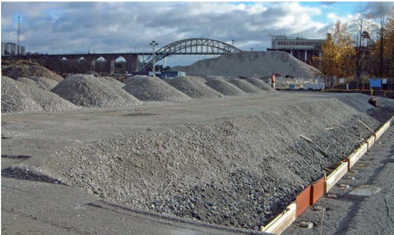
Figur 22. Betongkrosshögar och överbyggnad av betongkross på f.d. Vin&Sprints område i Årstadal i Stockholm. Över 50 000 ton betong från rivna byggnader återanvändes som högkvalitativt gatubyggnadsmaterial (foto: JM).
