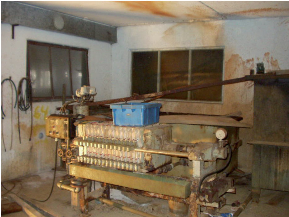
Figur 3. Filterpress som visar hur spill på väggar koncentreras till den nedre delen av väggarna, men att pressningen har gett upphov till kraftigt spill även i taket. (Foto: Golder Associates)
