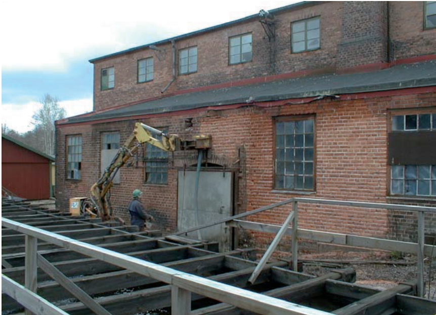
Figur 2. Sanering av ytskikt (foto: Golder Associates).
