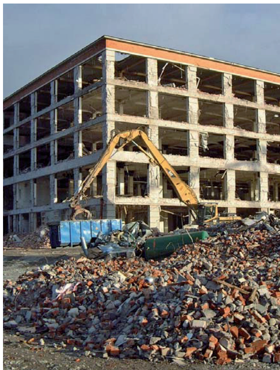
Figur 21. Om förorenat byggnadsmaterial rivs måste avfallet klassificeras. Ska det återanvändas måste det dessutom vara noggrant separerat (foto: JM).
